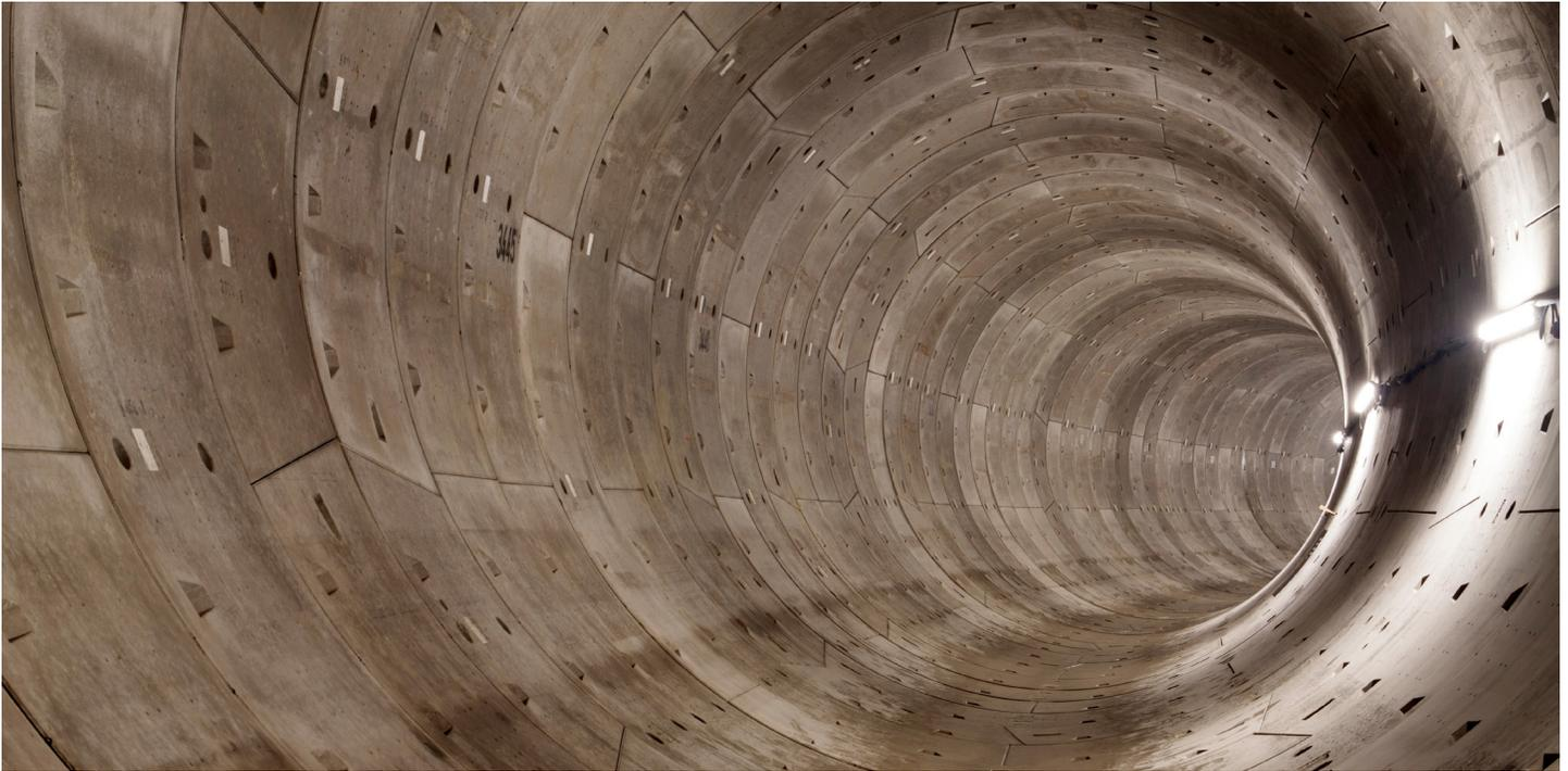
內部視圖顯示的水泥段設計表明,隧道能夠比上方地面結構更好抗震。
